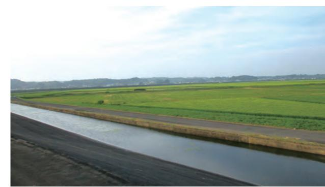
水害に悩まされてきた品井沼を干拓し、農業で大崎耕土の恵みを享受しつつ、大規模な洪水には水稻が比較的湛水を許容する性質を活かし、河川からの水を一部水田に一時的に貯水(372ha)し、他の水田や集落への被害軽減を図っています。
