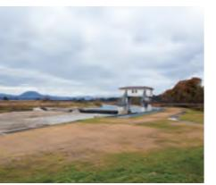
鳴瀬川支流の田川から用水を取り水するための堰。文永4年(1267年)から12年かけて築造されました。現在の加美町中新田地域を潤しています。蟻堰を通じて灌漑された水は田川に落水し、館前堰の水源として再利用されています。
