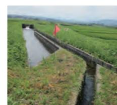
荒川堰用水路にある12の隧道・潜穴の上流部にある潜穴(水路トンネル)。原潜で直角に曲がり、東方向に向きを変え、旧石器時代の遺跡がある丘陵地帯に向かって伸びていく。付近には現在でも穴堰という地名が残っています。
