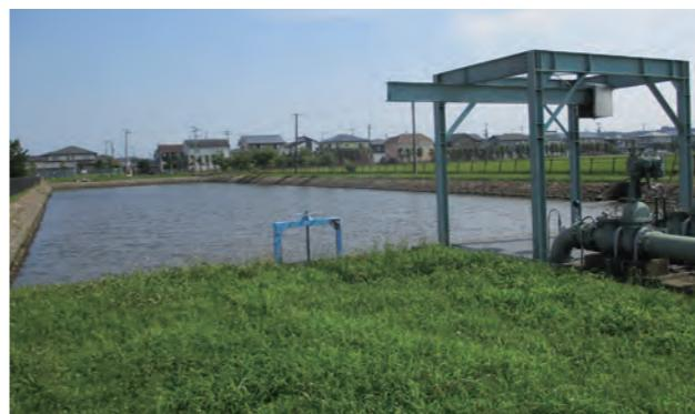
水が不足しがちな中下流域で用水を確保する手段として、ため池が数多く設置されており、大崎耕土全体で1,152箇所におよびます。排水路の水を嵩上げして反復利用すること併せ、用水を確保する巧みな水管理が行われています。
