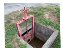
排水路の上流と下流の境に八寸角(24cm)の穴を設け、洪水時に流下する水量を制限する仕組み。洪水時は上流地区も浸水させ、下流地区的浸水被害の集中を抑制し、地域全体を考えた水管理の知恵が継承されています。
